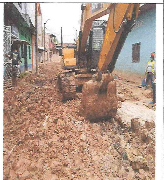
Excavación de zanja canal en calle sr. Sipán
