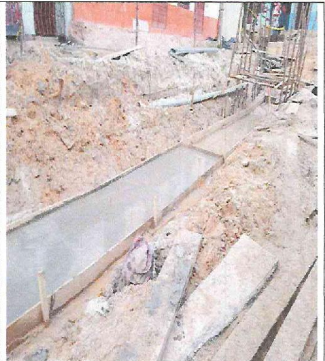
Llenado de mortero para solado e=10cm.
